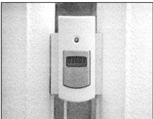
3 pav. Šildymo mokesčių daliklis (šilumos detektorius)
